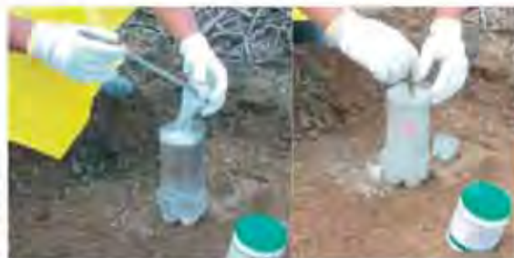
Se debe hacer premezcla para evitar grumos dentro de la máquina de aspersión que pueden tapar la boquilla.
