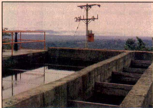
También se busca incentivar la construcción y mejoramiento de las plantas de tratamiento.
