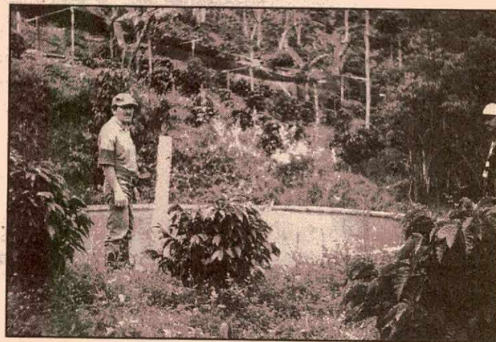
Tanque casquete para el almacenamiento de agua, con una capacidad de 100 metros cúbicos.
