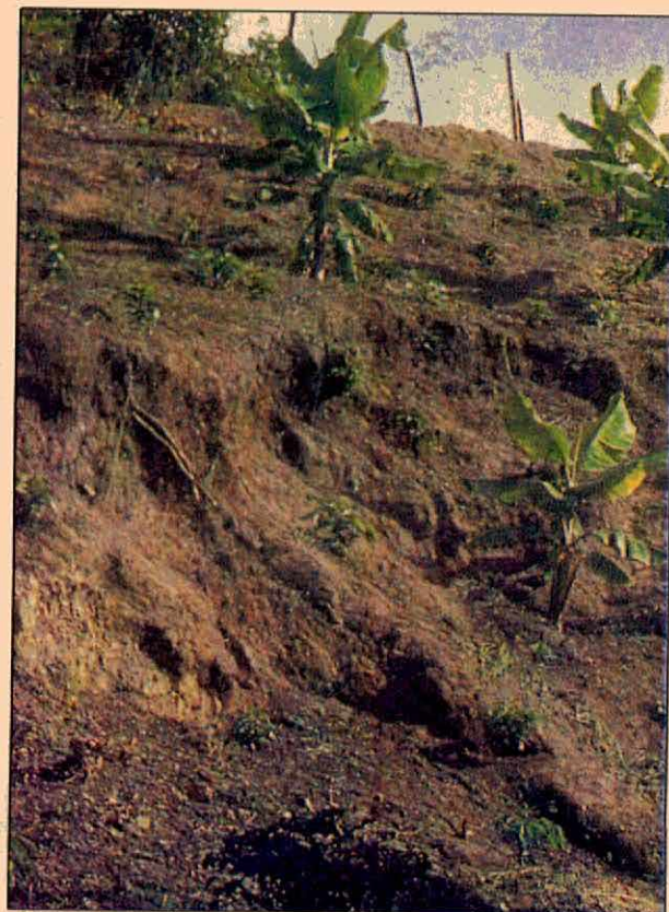
Suelo removido por el azadón y arrastrado por las aguas lluvias.
