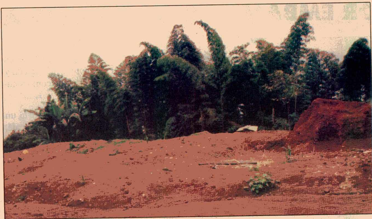
El relleno sanitario hace parte del manejo integral de basuras.
