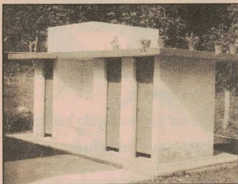
Unidad sanitaria y pozo séptico, obra comunitaria en la vereda Las Catorce. Así se mejoran las condiciones de higiene y no se contaminan las fuentes de agua.
