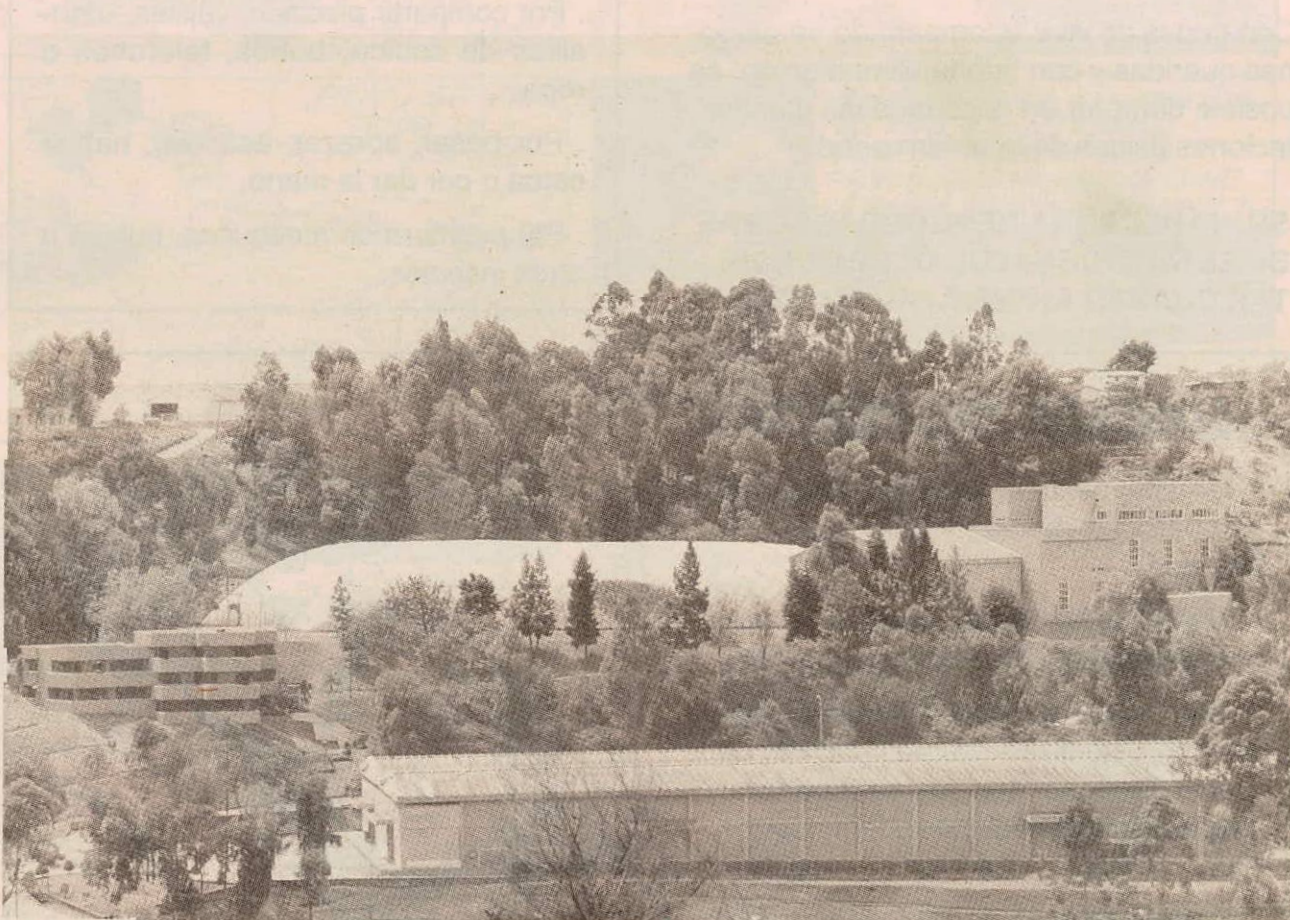
Sede de ALMACAFE en Manizales. Se observa una bodega convencional, las oficinas, una bodega inflable
