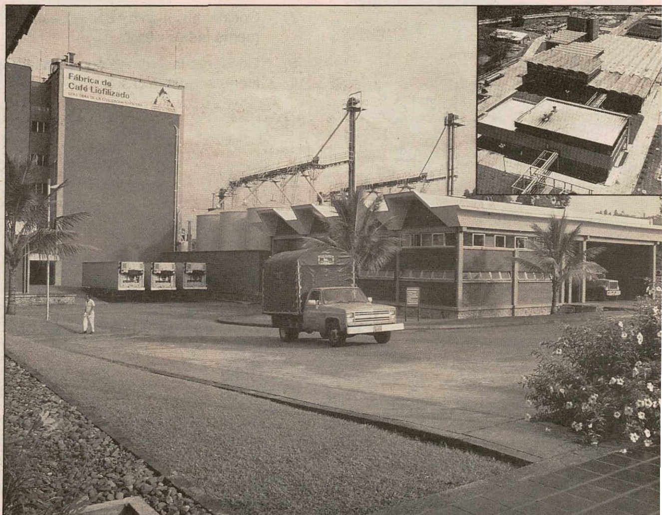
En la Fábrica, ubicada en Chinchiná, además de café liofilizado, se produce extracto de café congelado, para exportar.
