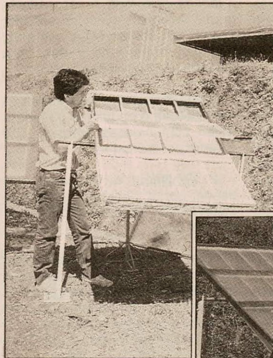
Ultimamente Cenicafé entregó el diseño del secador rotativo solar, que es una pasera con malla o anjeo por ambos lados que gira sobre un eje central.
