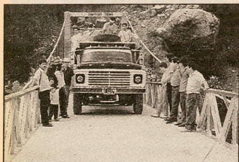
Puente Mosquera, Melgar
