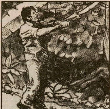
1. Rocería de las zonas laterales de la vía. La limpieza de las zonas laterales permite tener una buena
