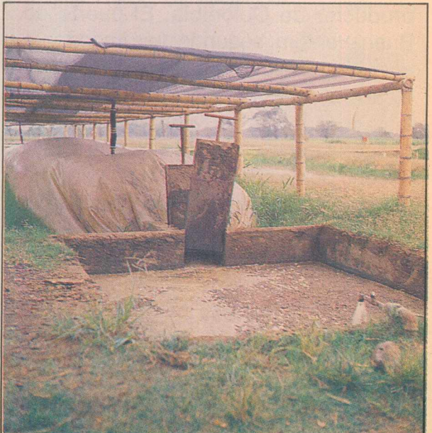
"CAJA DE CARGA Y BIODIGESTOR"
