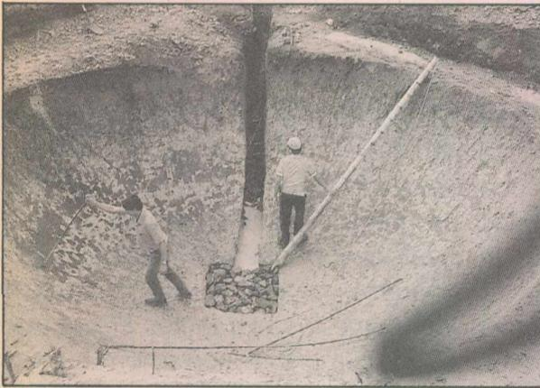
Luego de adecuado el terreno se procede a hacer la excavación del casquete, que en este caso tendrá una capacidad de 20 mil litros, o sea lo que hacen 20 tanques corriente de asbesto.
